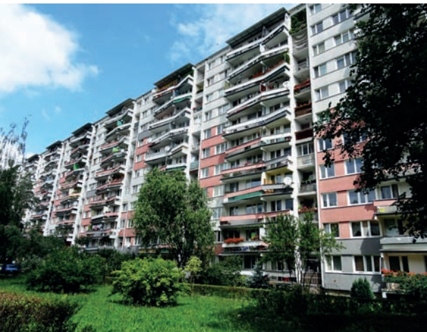
Blok „mrówkowiec” na wrocławskim osiedlu Popowice, 13 lipca 2017 r.
